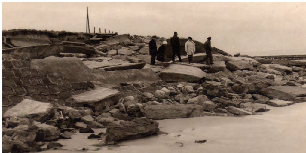
Abb. 4: Zerstörtes S-Profil-Deckwerk am Westkopf der Insel Baltrum 1962
